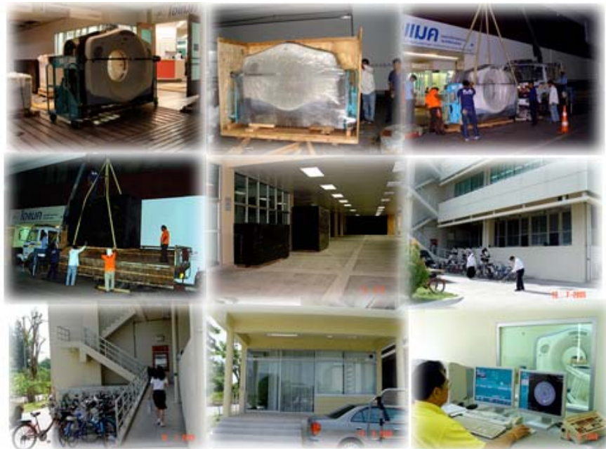
ภาพลำดับเหตุการณ์จากเริ่มขนย้ายเครื่องซีทีมาเก็บไว้ การเลือกสถานที่สร้างอาคารห้องปฏิบัติการเอกซเรย์คอมพิวเตอร์ จนสร้างอาคารเสร็จ และติดตั้งเครื่องซีทีจนใช้งานได้
